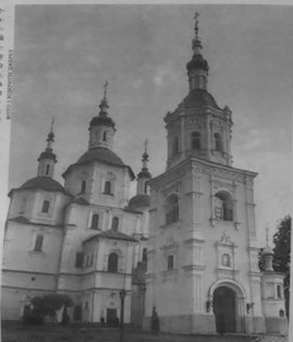
А ВОСКРЕСЕНСЬКА ЦЕРКВА — це лийн найдревніша споруда міста, а й унікальна архітектурна пам'ятка, побудована в стилі перехід між українського і російського зодчества
